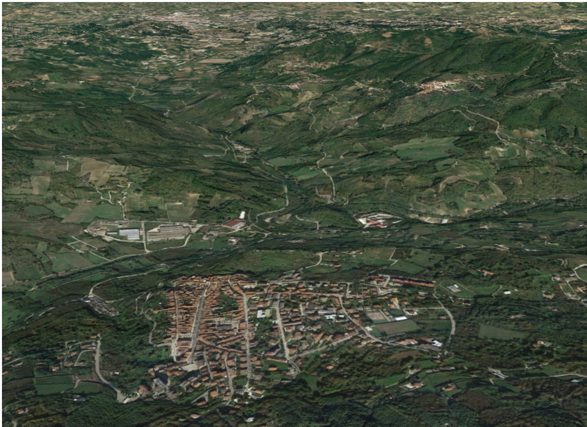
Fig. 2. Altavilla nella prospettiva verso nord: si nota la confluenza del torrente Vellola nel fiume Sabato (ai piedi di Altavilla, nei pressi della miniera) e la gola del fiume che si allarga verso l'urbanizzato di Benevento, sullo sfondo.
